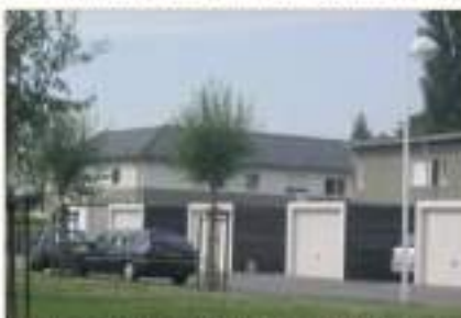
Les garages éloignés le long de la rue structurent le front bâti.
